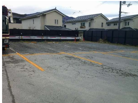
岩倉村松転回場路面ライン再塗装および不整地用ラインテープ再施工
