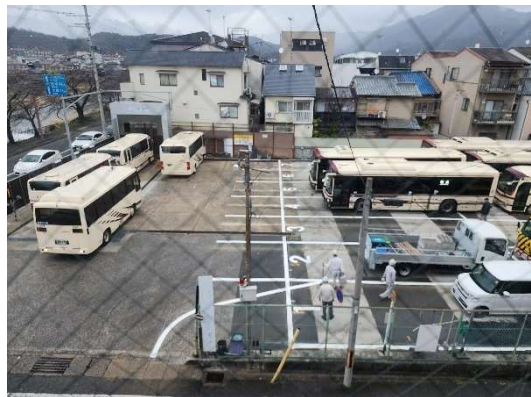
高野営業所北車庫の駐車枠拡大によるライン再塗装
