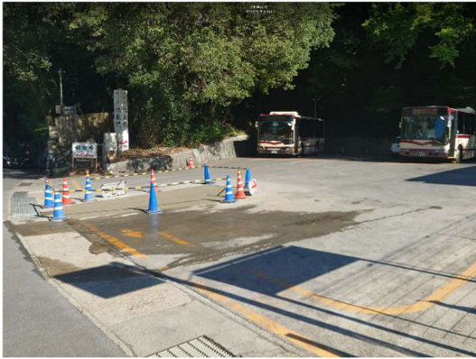
苔寺転回場路面補修
