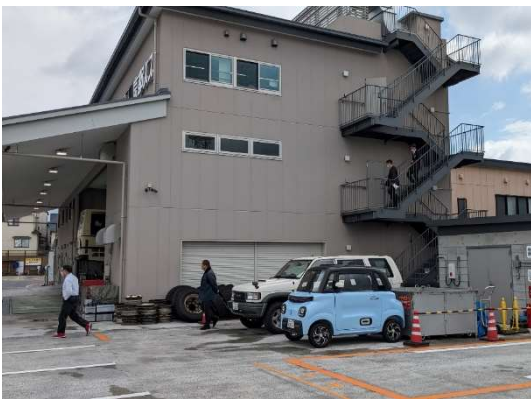
高野営業所建物火災訓練
